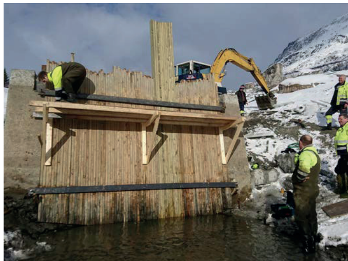
Nålestengsel ble montert ved inntaket til Fremste Kaldhussætervatn før revisjon av tappetunnelen kunne settes i gang.
