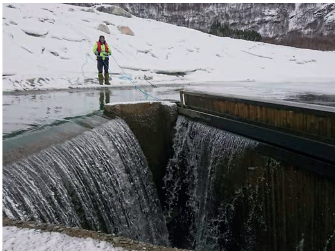
I februar ble det gjennomført nedtapping av Fremste Kaldhussætervatn. Dette grunnet vedlikeholdet som skulle gjennomføres på tappeventilen fra Heimste Kaldhussætervatn.
