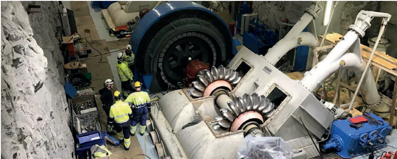
Vedlikeholdsarbeidet relatert til kraftstasjonen Tafjord 2 startet i februar og ble avsluttet i juni.
