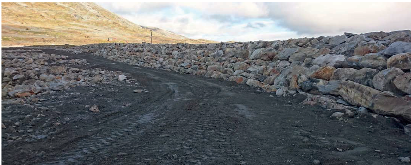
Dam Kolbeinsvatn nedstrøms etter oppgradering.
