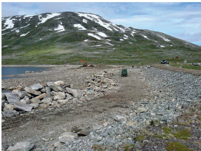
Dam Kolbeinsvatn før oppgradering.
