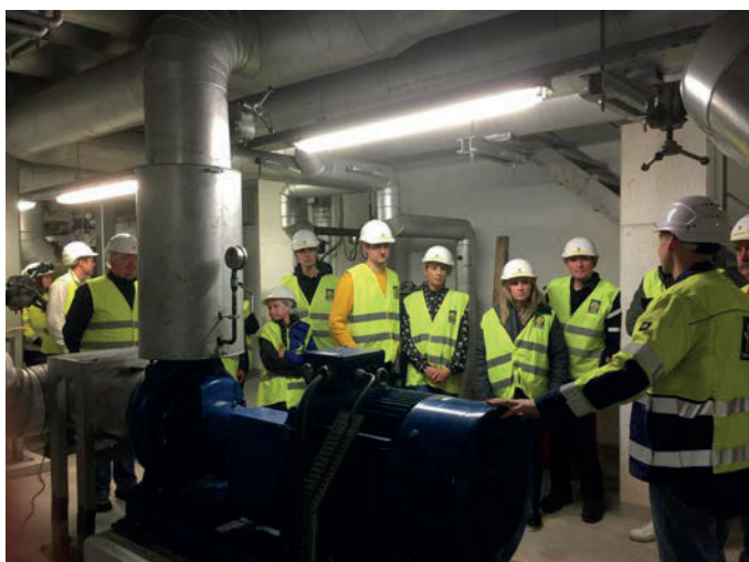
Facebook-venner på besøk ved Energigjenvinningsanlegget.
