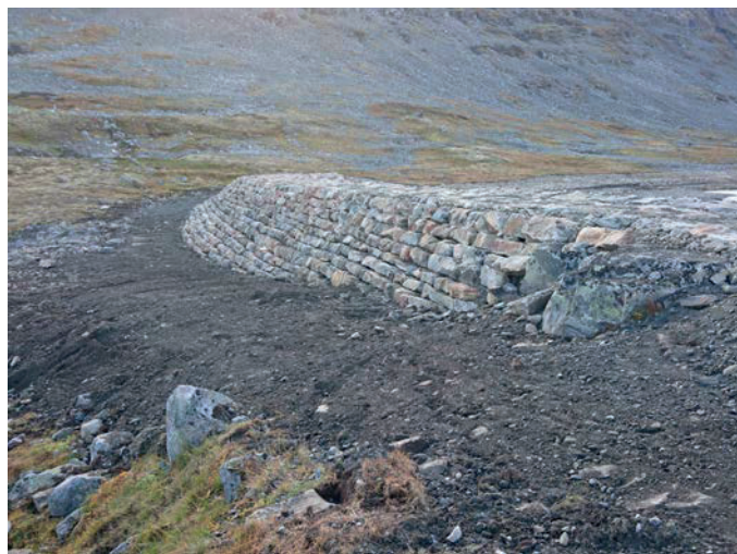
Dam Kolbeinsvatn oppstrøms etter oppgradering.
