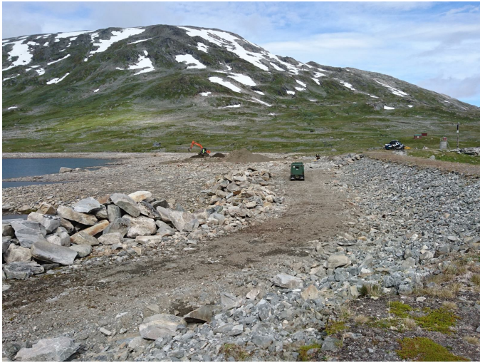
Dam Kolbeinsvatn før oppgradering.
