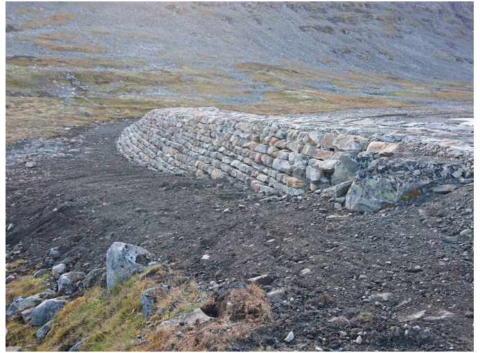
Dam Kolbeinsvatn oppstrøms etter oppgradering.
