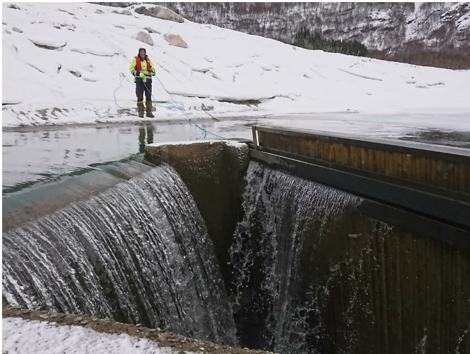
I februar ble det gjennomført nedtapping av Fremste Kaldhussætervatn. Dette grunnet vedlikeholdet som skulle gjennomføres på tappeventilen fra Heimste Kaldhussætervatn.
