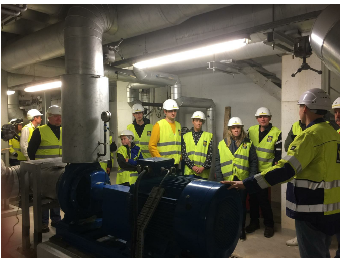
Facebook-venner på besøk ved Energigjenvinningsanlegget.
