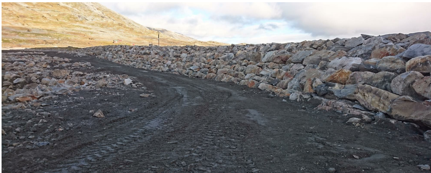
Dam Kolbeinsvatn nedstrøms etter oppgradering.
