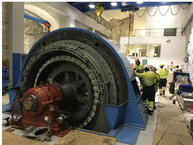
Vedlikehold pågår inne i Tafjord 2.
